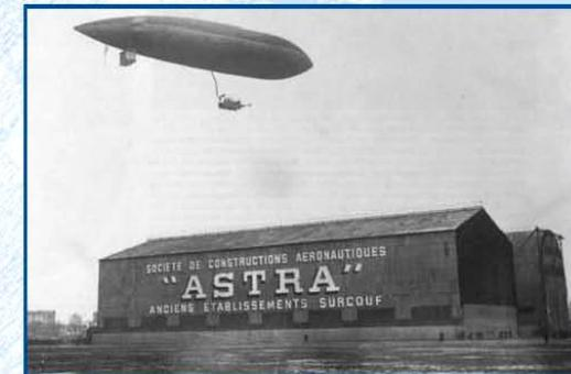
Las pruebas de recepción del "Astra-Torres XIV" en julio de 1913 constituyeron un nuevo éxito: se bate el record mundial de velocidad de un dirigible, alcanzando los 83,2 km/h. El Almirantazgo encarga el "Astra-Torres XVII" de 11327 m<sup>3</sup> y el "Astra-Torres XIX" de 3960 m<sup>3</sup>.
